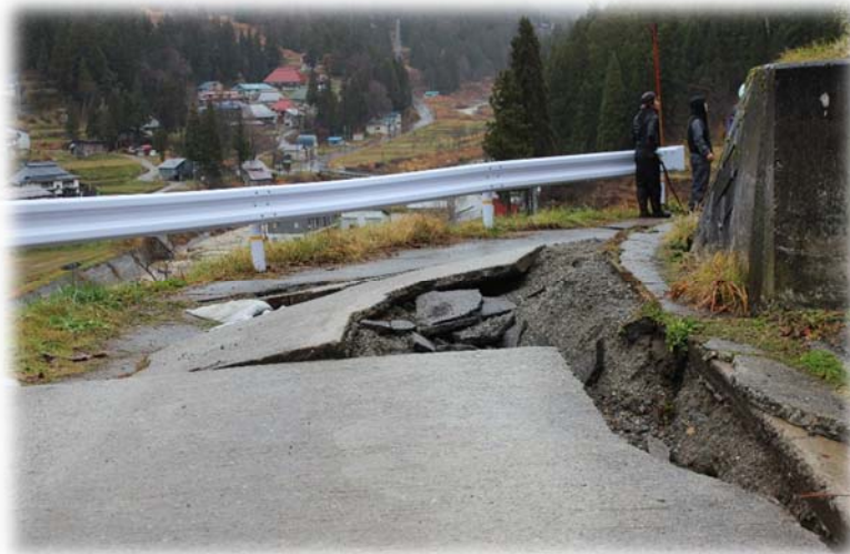
神城断層地震で陥没した道路(11/25 小谷村)
